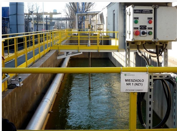
Osadniki wstępne wody pobieranej w Wisły do procesu technologicznego
