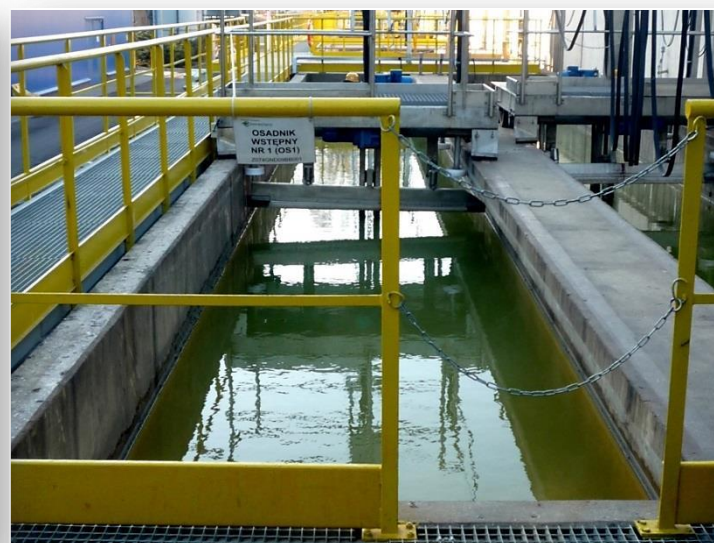
Osadniki wstępne wody pobieranej w Wisły do procesu technologicznego
